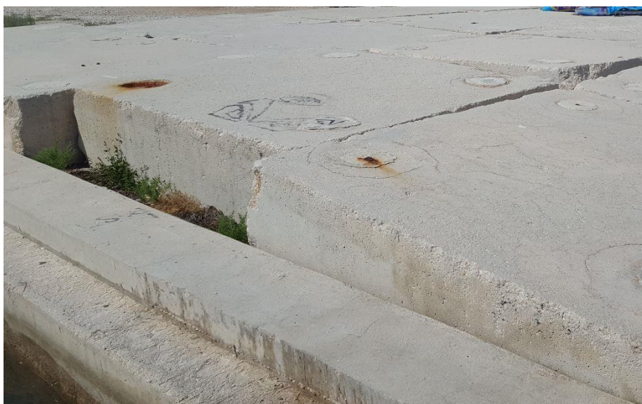
Slika 4. – postojeći betonski blokovi na postojećem platou
