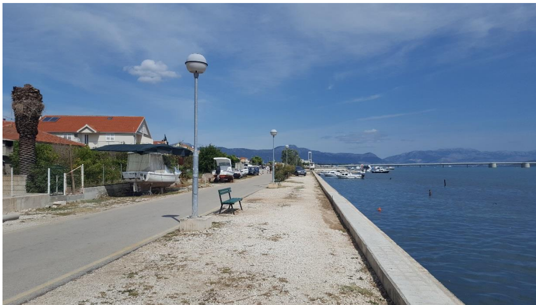
Slika 1. – Postojeći obalni zid ( izveden prema glavnom projektu IGH d.d.) i neuređena zaobalna površina
