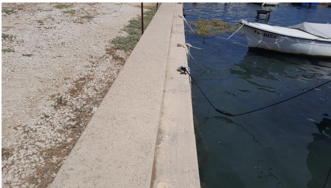
Slika 2. – Ostavljeni utori za postavljanje kamenih poklopnica i neuređena zaobalna površina
